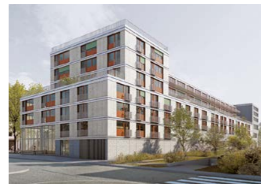
Neubau der Genossenschaft zusammen_h_alt und ZHAW
